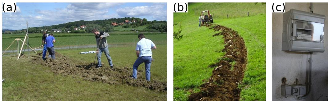
Abbildung 3.7.: Installation der Energieversorgung am Beispiel einer Primärstation: Verlegung des Erdkabels mit Unterstützung (a) von SchülerInnen regionaler Fachschulen und (b) eines Grundstückseigners; (c) Montage eines Sicherungskastens.
