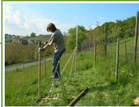
Errichtung der Grundinfrastruktur
